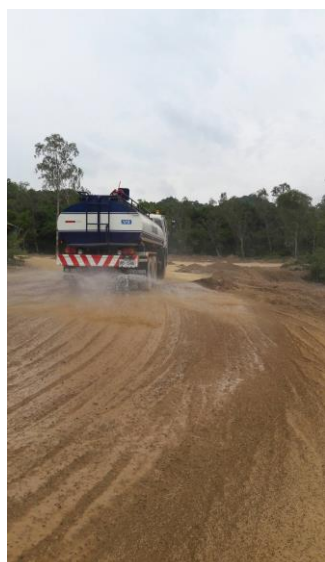
รูปที่ 5 การฉีดพรมน้ำบริเวณเส้นทางขนส่งแร่และบริเวณหน้าเหมือง
